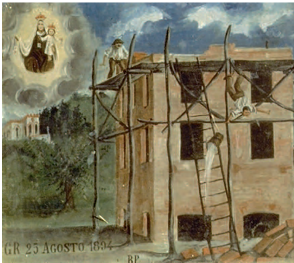
1894, 25 agosto, Incisa Scapaccino (At), Chiesa Madonna del Carmine. Caduta dal ponteggio durante lavori di muratura [foto R. Grimaldi, 1987]
