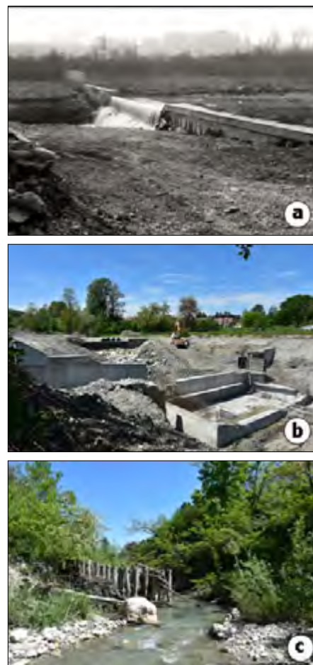
Figura 9. Una briglia realizzata sul Torrente Tiepido (a) nel 1979 (la terza di figura 3) e (b) la ricostruzione dell'ultima della serie crollata nel 2019. Un tentativo di ingegneria naturalistica, (c) dove sono stati utilizzati materiali naturali in sostituzione del calcestruzzo, senza tener conto che anche i criteri progettuali dovevano essere diversi, con evidenti risultati negativi
