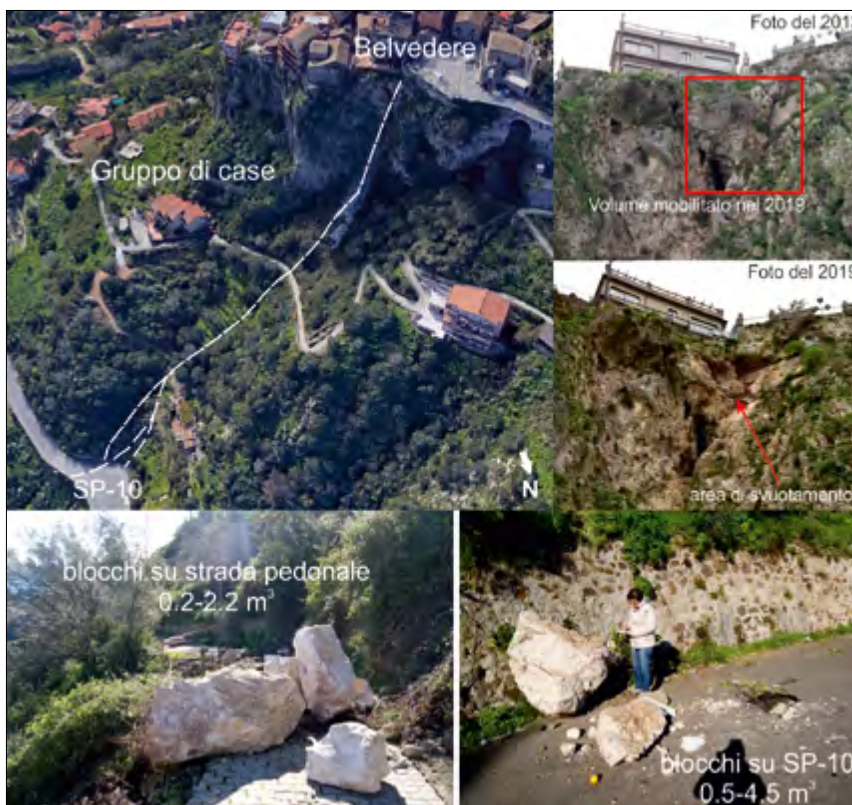
Figura 6. Frana del 5 gennaio 2019
