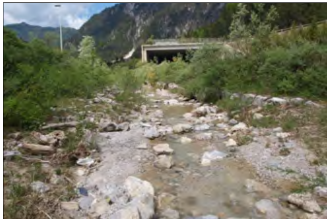
Fiume Fella, post operam, maggio 2011
