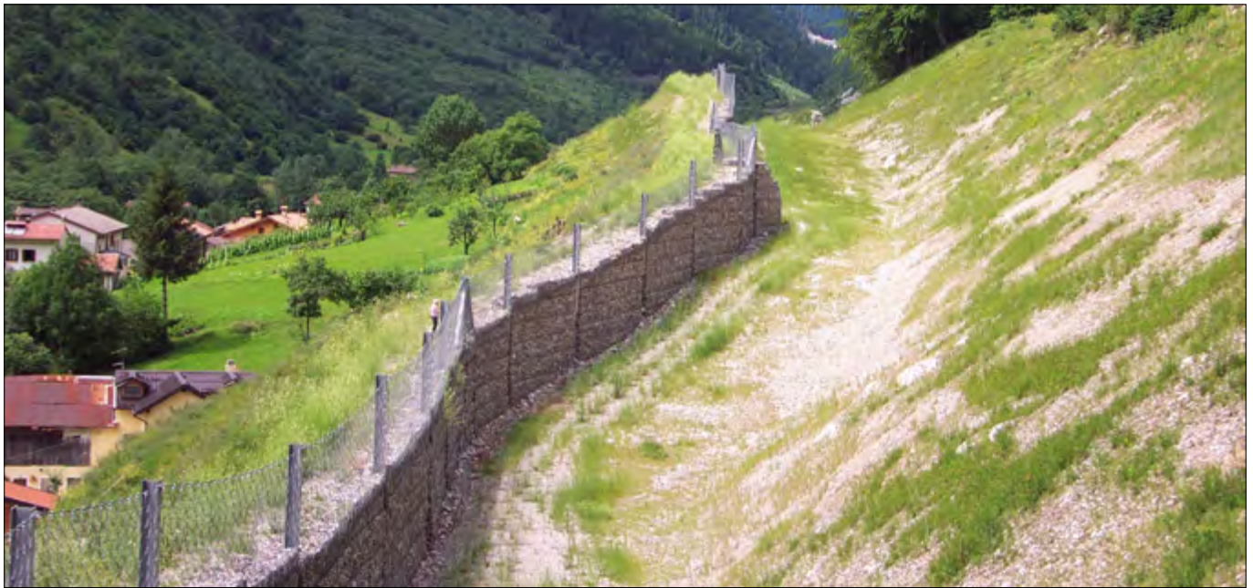
Figura 5. Sistema vallo rilevato con rete a difesa dell'abitato di Timau comune di Paluzza. Ampiezza media vallo 12,5 m, altezza intercettazione totale 8 m
