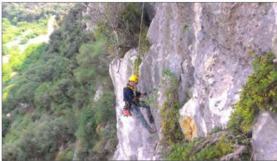
Figura 5. Fasi esecutive dei rilievi geostrutturali e geomeccanici
