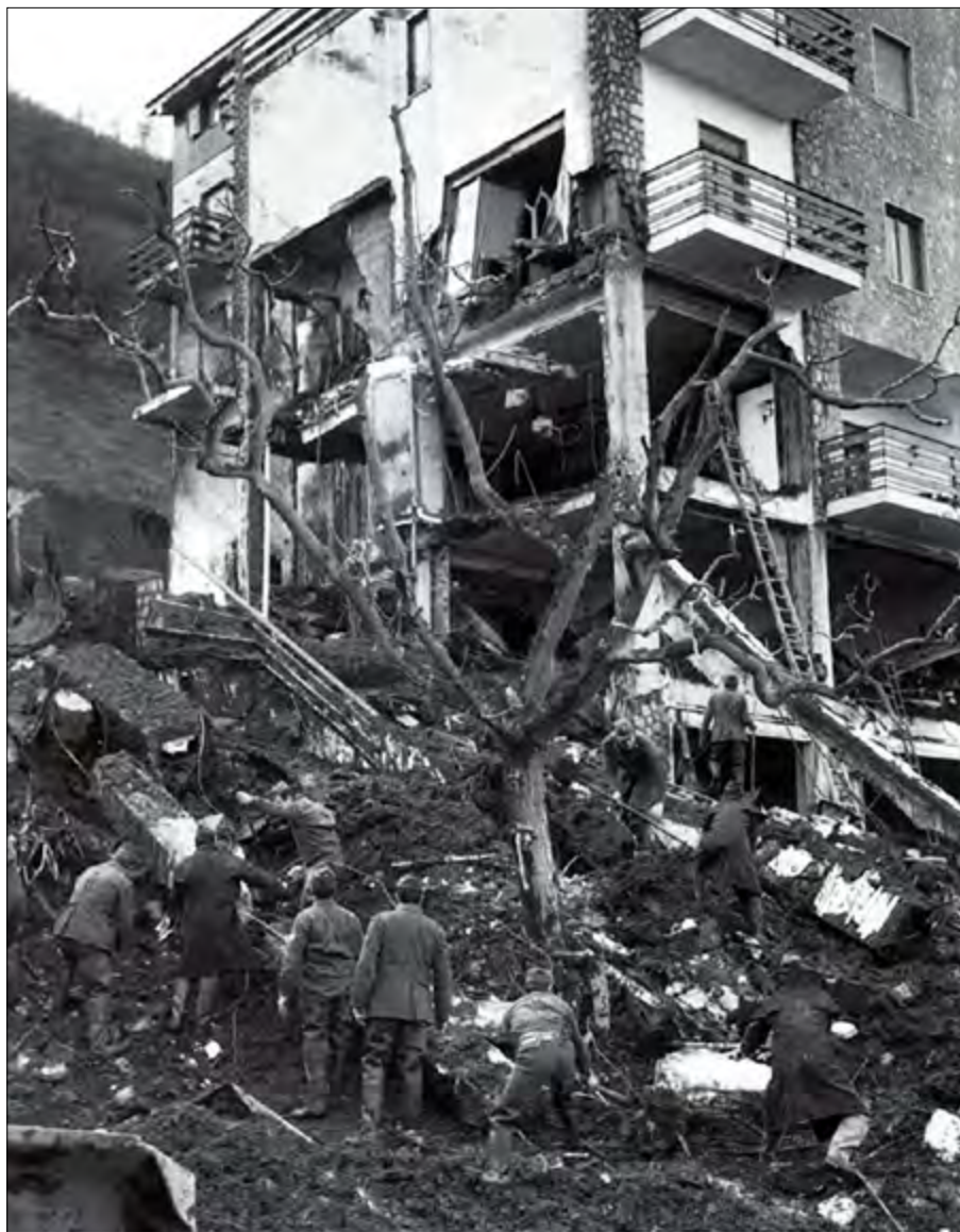
Figura 5. L'hotel La Selva parzialmente distrutto dalla colata di fango del 2 gennaio 1971 (fonte: Catenacci V., 1992)
