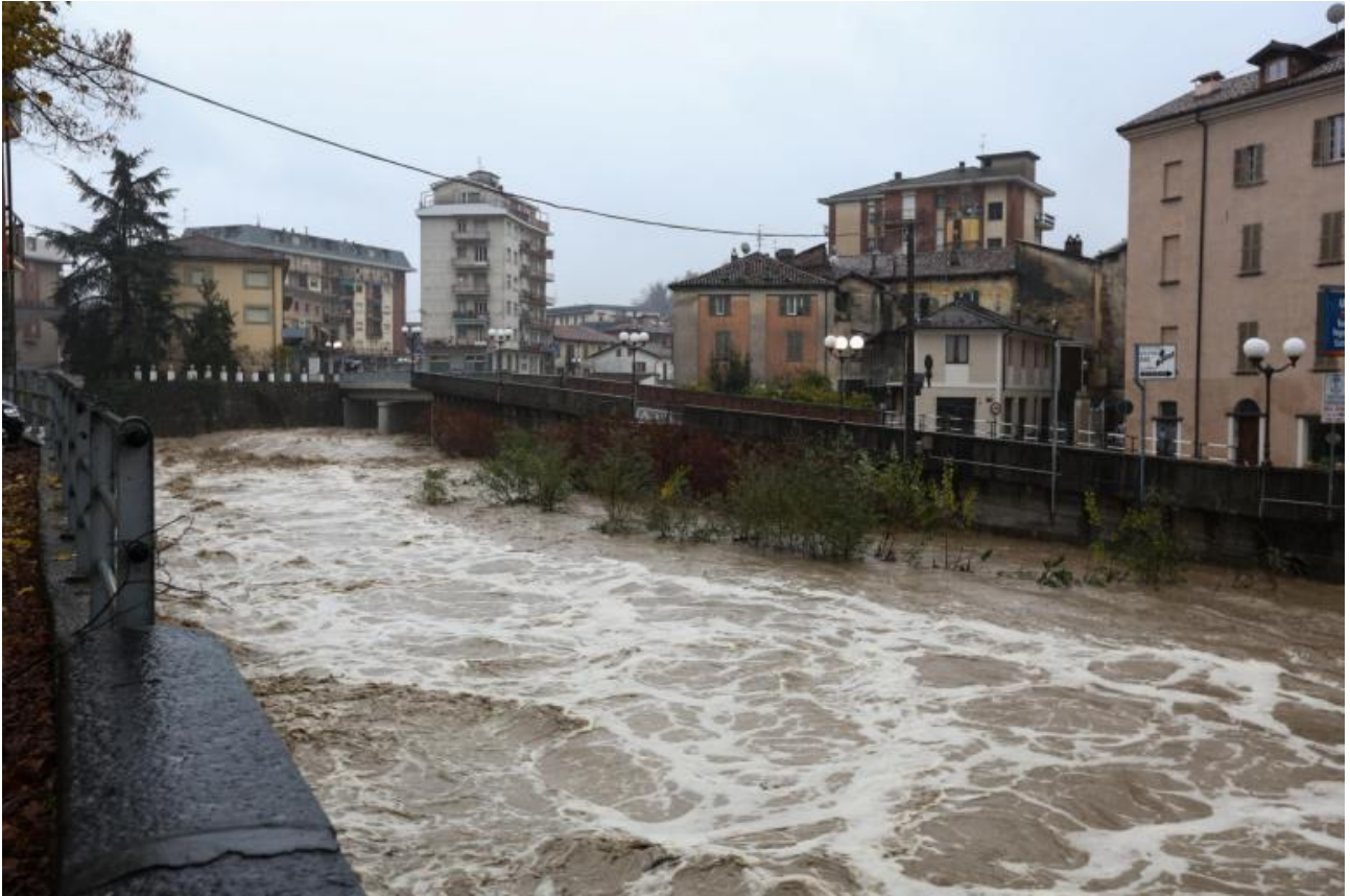
Figura 13 – Evento alluvionale del 21-25 novembre 2016: in corrispondenza della sezione C1, le impetuose acque del T. Cevetta sono fortunatamente rimaste al di sotto anche degli argini naturali (Rif. WEB n. 2).
