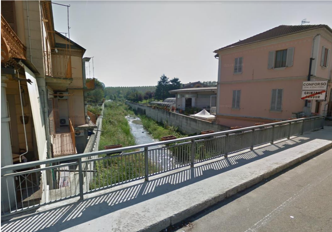
Figura 6 – Ubicazione della sezione 1, immediatamente a monte del ponte sul T. Talloria di Sinio, posto al confine tra il comune di Grinzane Cavour e quello di Diano D'Alba: le case si trovano addossate al corso d'acqua.
