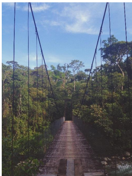
A bridge close to CIPCA (Henna Puustinen 2015)
