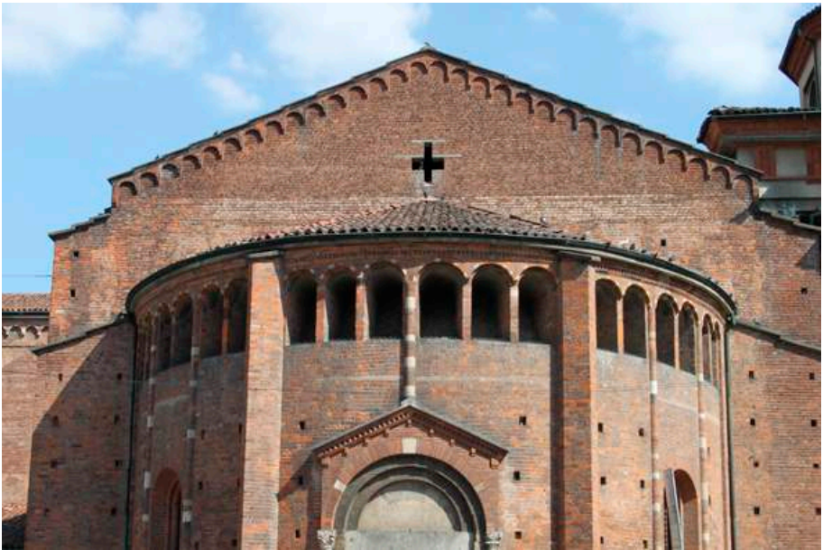
Fig. 19 Milano, basilica di San Nazaro, (vista dall'esterno della basilica–abside transetto nord).
