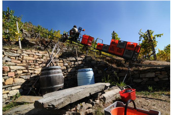
05 Viticulture héroïque: le monorail de Pomaretto (TO), construit en 2003 pour faciliter la culture des vignes en forte pente | Viticoltura eroica: la monorotaia di Pomaretto (TO), costruita nel 2003 per facilitare la coltivazione nei vigneti in forte pendenza.
