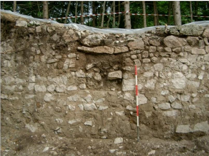
*fig. 27* – Muratura interna del lato Nord della torre 1, con nicchia ricavata nel muro.
