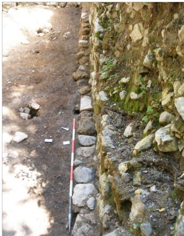
fig. 17 – La risega di fondazione e i buchi di palo dei ponteggi realizzati per edificare il muro sud della torre 1.
