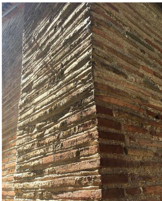
Fig. 8. San Vitale (RV), doppia lisciatura dei giunti di malta sul perimetro esterno del monumento.
