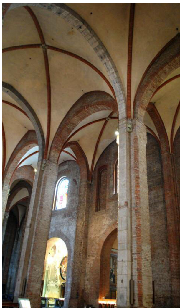
Fig. 3. Tracce di imposta degli archi originari alla sommità dei pilastri.
