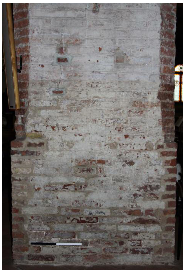
Fig. 4. Paramento occidentale del secondo pilastro della navata sud.
