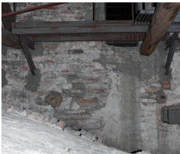
Fig. 10. Struttura muraria longitudinale nord nel sottotetto di San Simpliciano.
