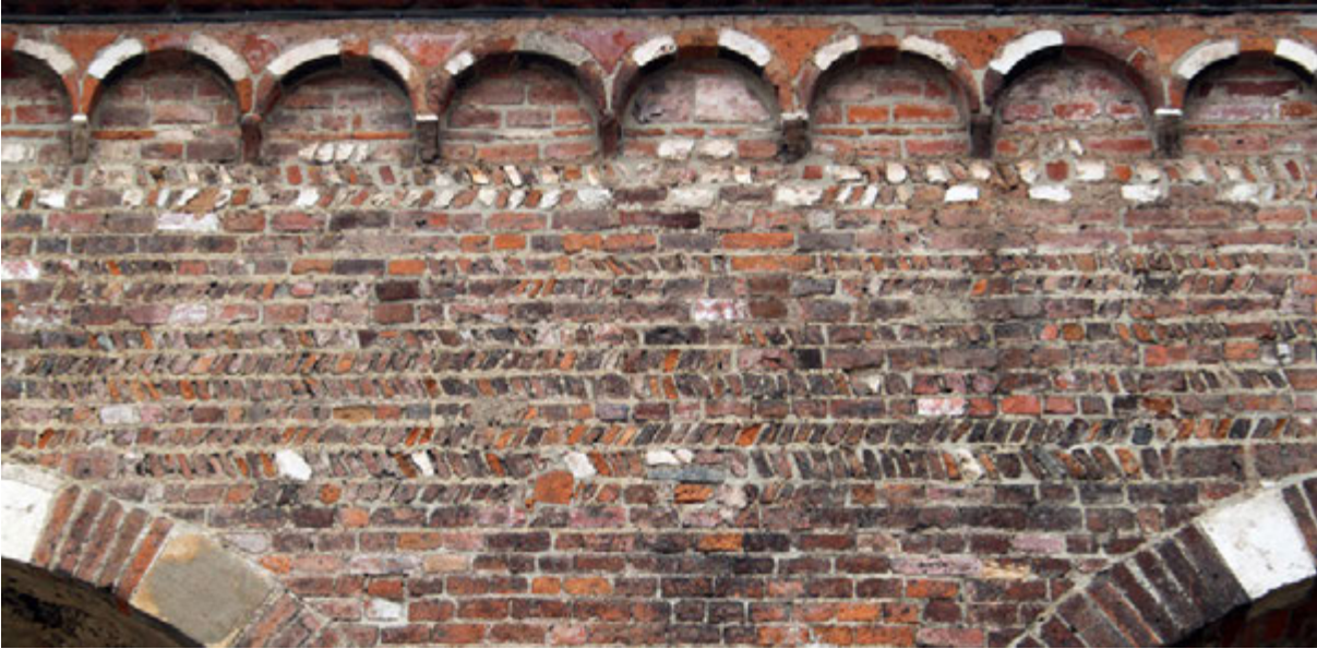
Fig. 2. Muratura a spina pesce sul fronte dell'atrio della basilica di Sant'Ambrogio (XI-XII secolo).
