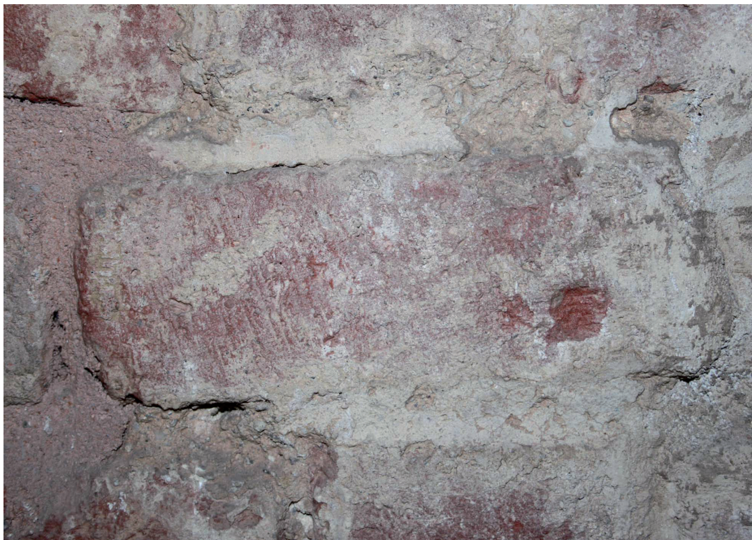
Parete settentrionale della chiesa dei Santi Giacomo e Filippo a Nosedo, 2012, particolare. Si nota la stilatura dei giunti e la rigatura della superficie di un laterizio
