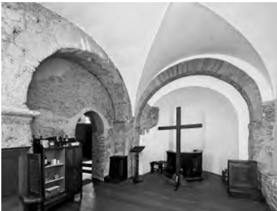
Fig. 6 - Saint-Vincent, parrocchiale; interno, penultima campata e abside della navata sud. Sulla sinistra, traccia del tamponamento che chiude l'arco a tutto sesto tramite il quale avveniva in origine il collegamento con il presbiterio; sulla destra, resti dell'absidiola (fotografia dell'autrice).
