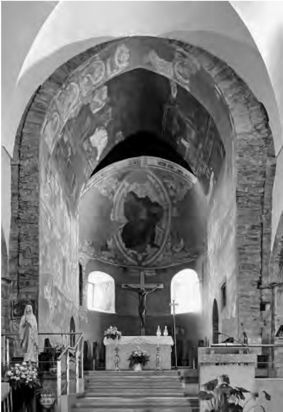
Fig. 7 - Saint-Vincent, parrocchiale; interno, presbiterio. Si nota ancora l'arco di trionfo originario in cui, in particolare sul lato sud, sono evidenti le tracce di pesanti dissesti strutturali, arginati nella prima metà del XV secolo dall'inserimento di un nuovo sottarco in muratura addossato, senza cucire, a quello primitivo (fotografia dell'autrice).
