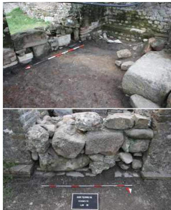
Fig. 14. Albintimilium ; tamponature delle soglie degli ambienti settentrionali dell'edificio: in alto, la tamponatura tra i vani VII e VI; in basso, la tamponatura tra i vani VI e VIII (foto I. Sanmartino).
