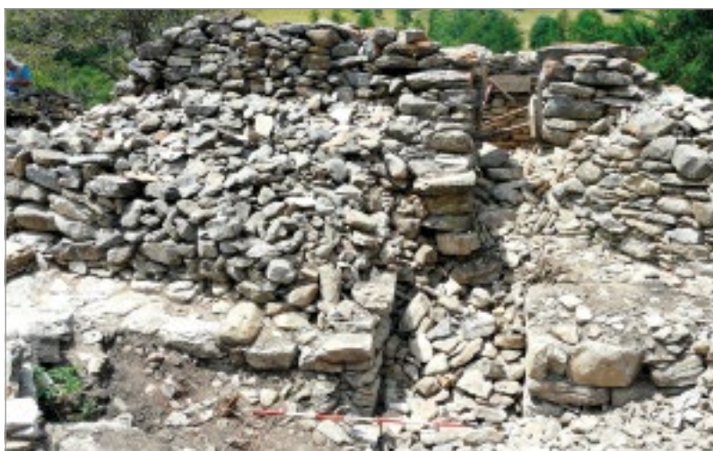
fig. 9a – Accesso alla ridotta.
