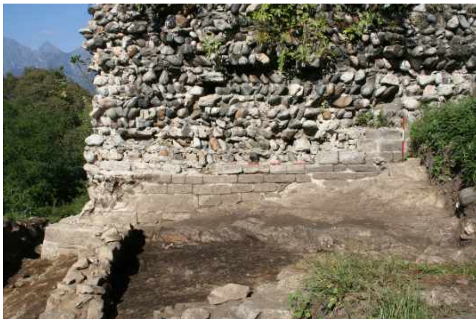
Fig. 13. Castrum Gravallone ; Area 3000: prospetto esterno del perimetrale sud dell'Edificio A (foto G.B. Parodi).
