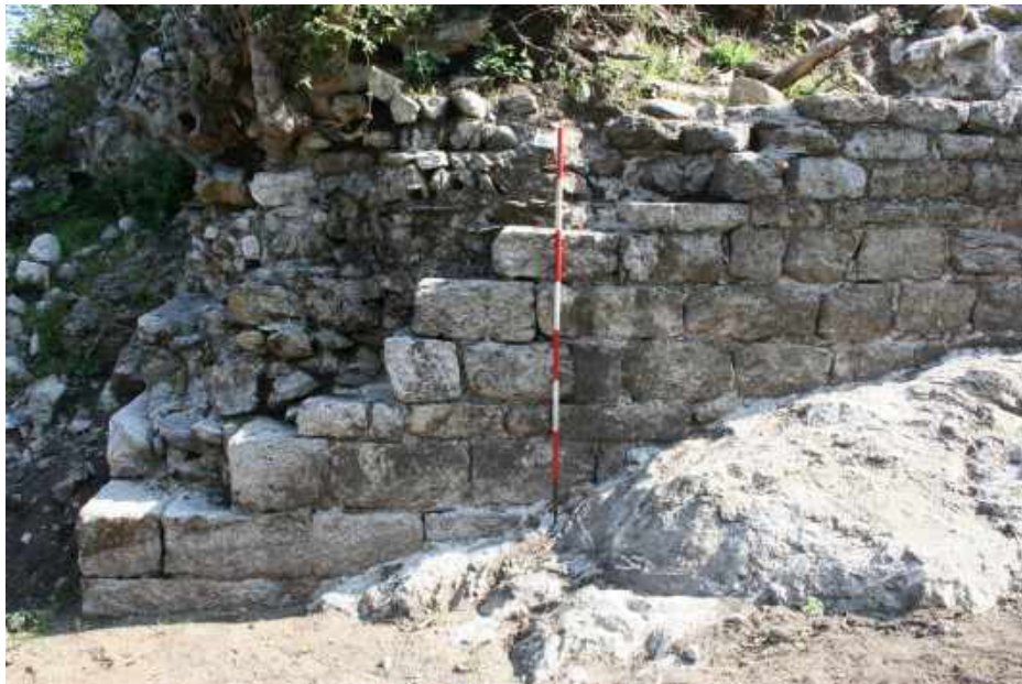
Fig. 6. Castrum Gravallone ; Area 2000: particolare del prospetto esterno del perimetrale ovest dell'Edificio C (foto G.B. Parodi).
