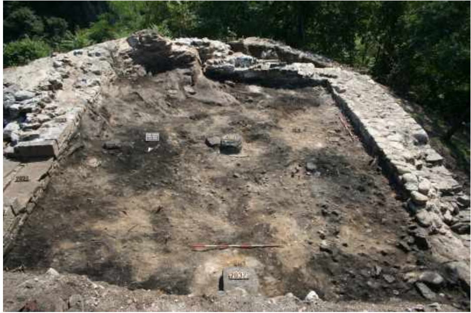
Fig. 8. Castrum Gravallone ; Area 2000: tracce della pavimentazione lignea carbonizzata dell'Edificio C, da nord (foto G.B. Parodi).
