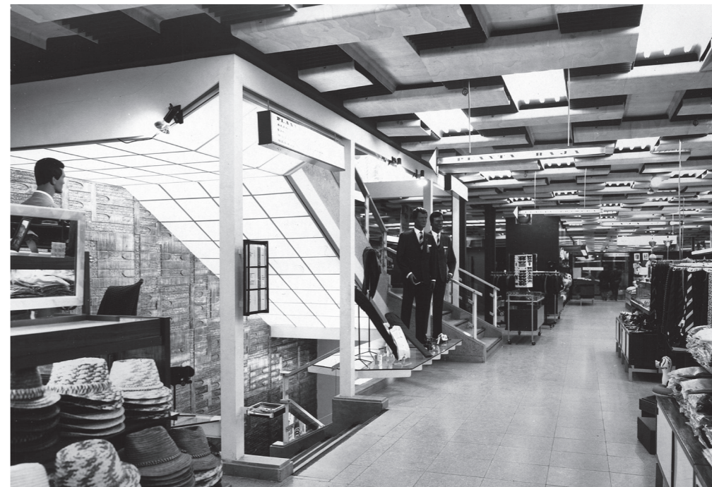
Img. 05 Interior de la ampliación de Almacenes Botas (nº 30 de Uría) concebida por Javier Feduchi en 1964 (Fuente: fondos del Legado Javier Feduchi Benlliure, Servicio Histórico del Colegio Oficial de Arquitectos de Madrid).
