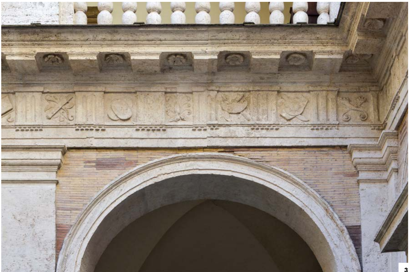
3. Roma, palazzo Baldassini, dettaglio della trabeazione dorica.
