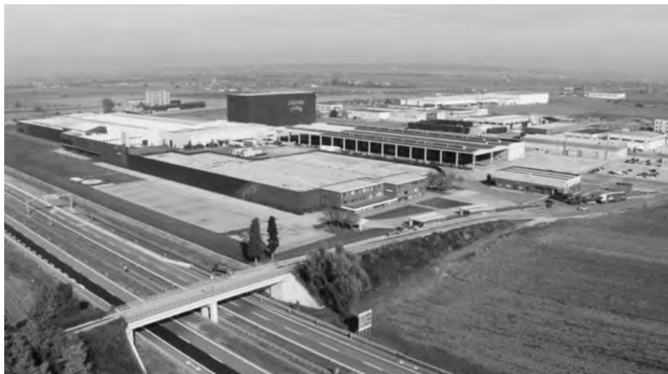
Fig. 1. PaneAlba, nuovo plant di Cherasco, ex area Sire Spa (fronte autostrada TO-SV, uscita Marene-Cherasco) (Archivio PaneAlba)
