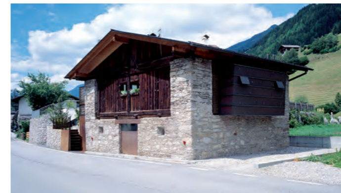
Figura 11 Em2 Architetti, risanamento di una casa in Valle Aurina (BZ), 2000-2004
