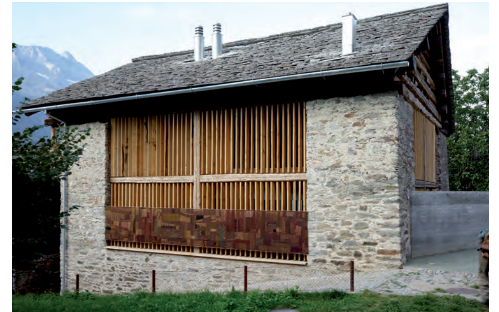
Figura 6-7 Armando Ruinelli, recupero di una stalla a Soglio, Svizzera, 2009
