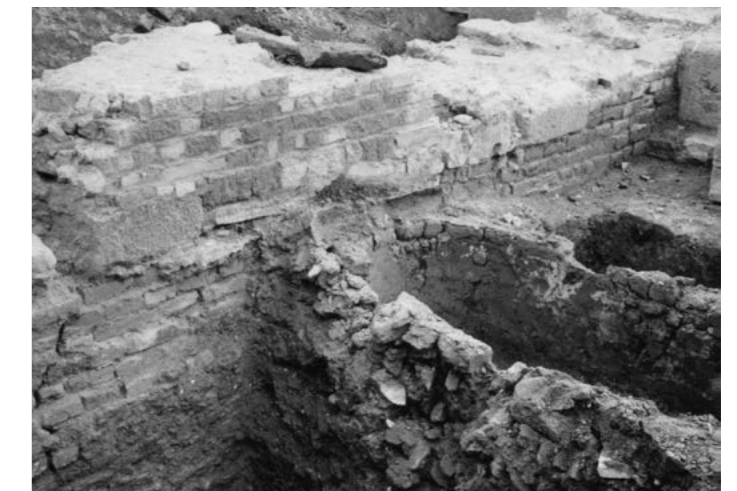
fig. 20 Santa Tecla, facciata, tipologia delle fondazioni
