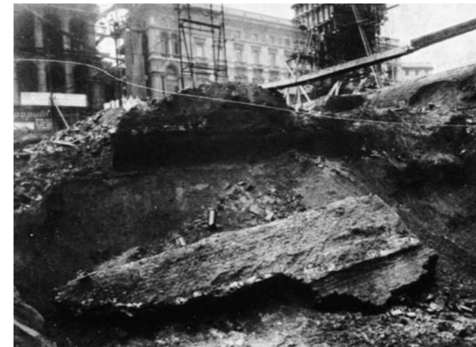
figg. 2-3 Fondazioni in conglomerato del perimetrale sud di Santa Tecla e soprizzo in laterizi di età romanica dagli scavi De Capitani
