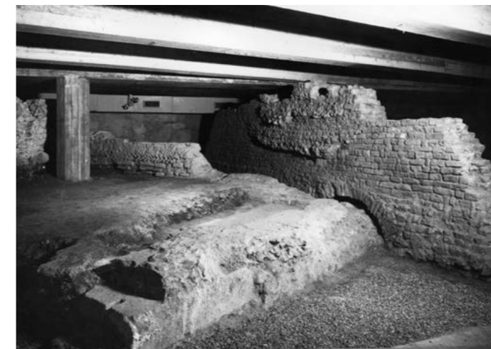
fig. 18 Struttura meridionale del vano di collegamento
