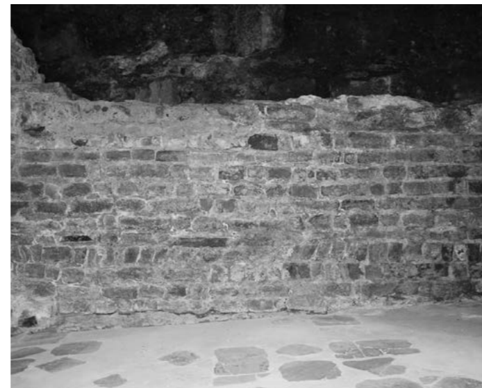
fig. 16 Tamponamento dell'accesso occidentale del battistero di San Giovanni alle Fonti
