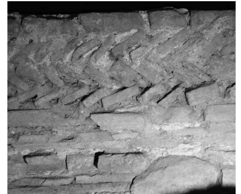
fig. 13 Tecnica costruttiva del perimetrale sud dell'aula triabsidata
