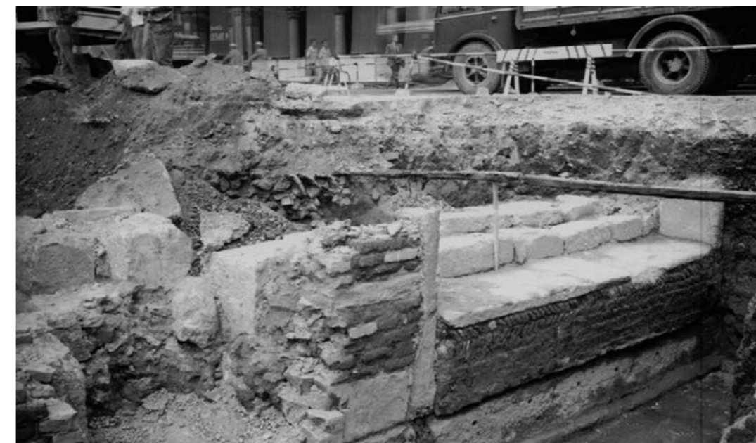
fig. 19 Sopralzo della soglia della cattedrale di Santa Tecla in una foto degli scavi del 1962
