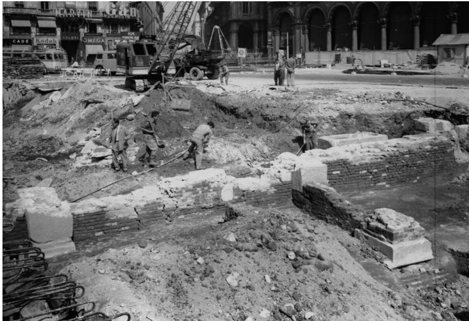
fig. 21 Santa Tecla, gli spolia in facciata
