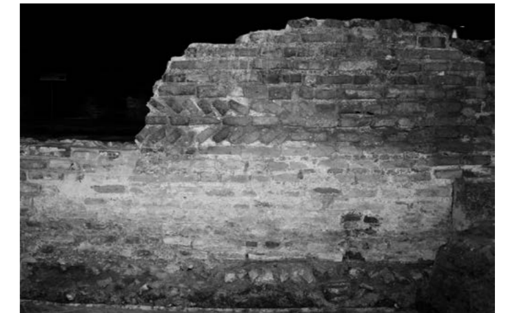
fig. 5 Tecnica costruttiva in opus spicatum e latericium dei perimetrali del battistero di San Giovanni alle Fonti (fine IV secolo)
