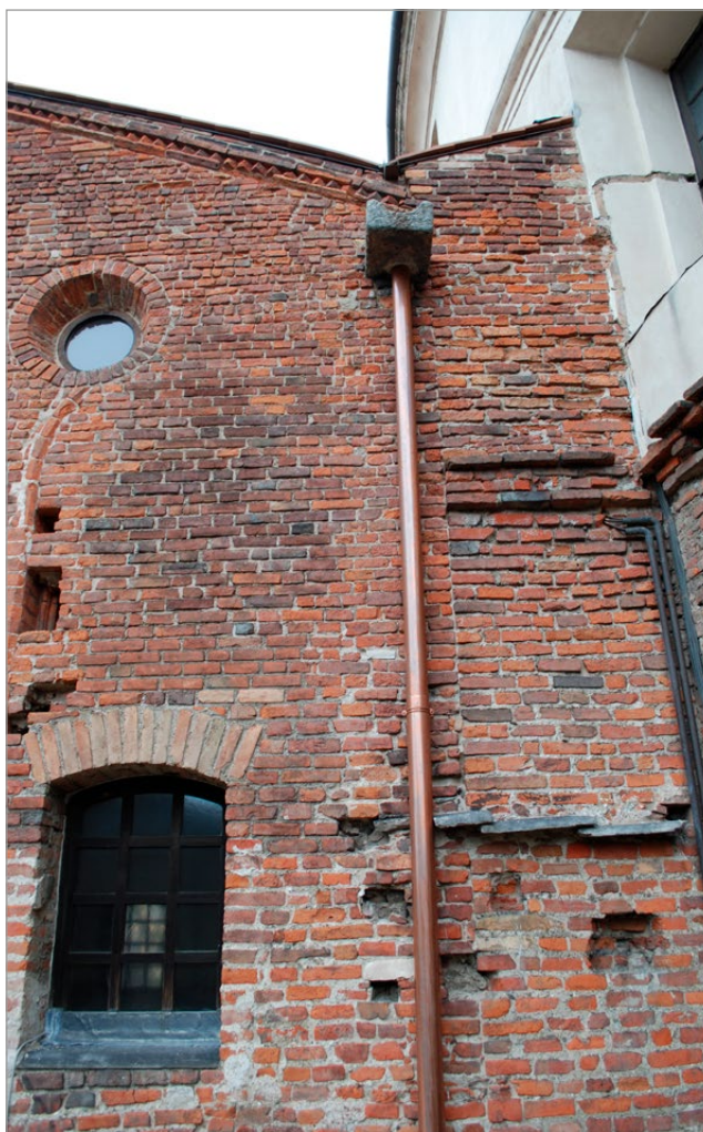
fig. 12 – Superficie di attesa tra struttura di raccordo del tetraconco e il perimetrale dell'atrio di Sant'Aquilino; a) Rapporto stratigrafico sul fronte ovest; b) Veduta del fronte est.
