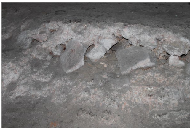
fig. 9 – Dettagli dalle fondazioni di Sant’Aquilino a) sezione del livello in cocciopesto; b) livello in cocciopesto a contatto con la fondazione continua dell’ottagono.
