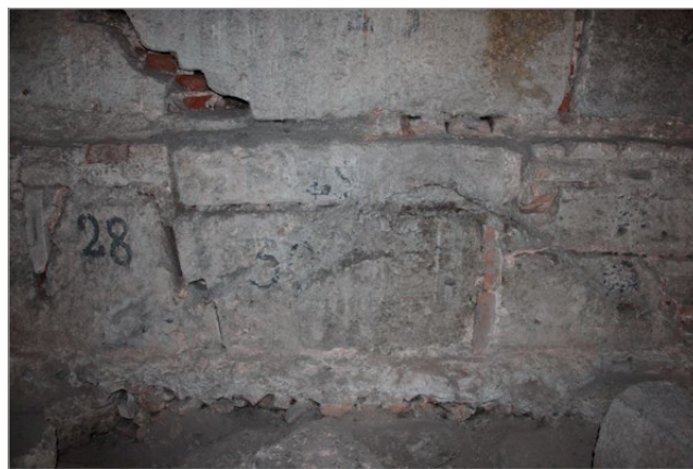
fig. 9 – Dettagli dalle fondazioni di Sant’Aquilino a) sezione del livello in cocciopesto; b) livello in cocciopesto a contatto con la fondazione continua dell’ottagono.
