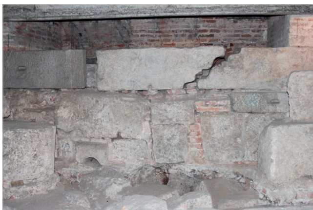
fig. 10 – Tecnica costruttiva con reimpiego di cornici modanate nella fondazione continua dell’ottagono.
