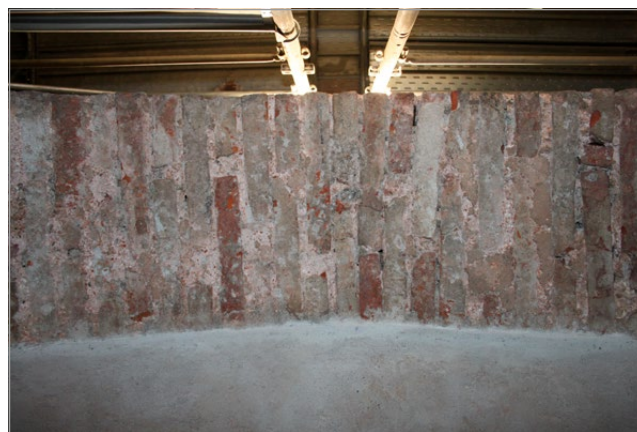
fig. 13 – Tecnica costruttiva degli arconi dell'atrio. a) Arco dell'abside occidentale. b) Particolare della tecnica costruttiva.
