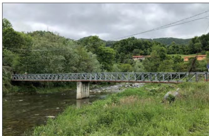
FIGURA 6. Ubicazione della sezione 1 a Rocca Canavese e sue dimensioni. L'attuale ponte è stato costruito in sostituzione del precedente, rovinato dall'alluvione del 1994.
