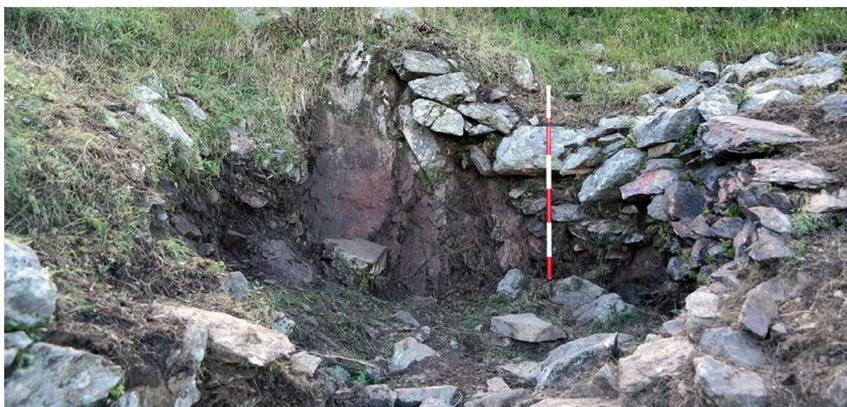
Figura 12. Fusine. Val Cervia. Forno di arrostimento a Sud della miniera. Particolare della camera di combustione in parte crollata e riempita di detriti (foto Ilaria Sanmartino).
