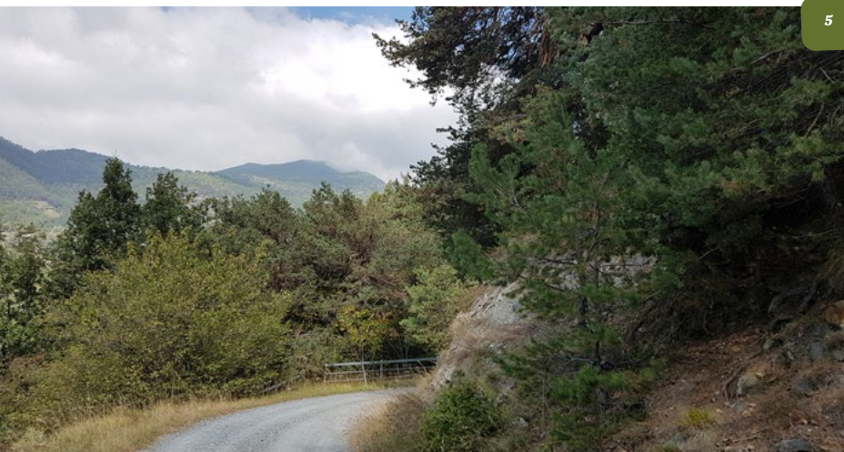
FIGURE 5 PEUPELEMENTS DE PINS SYLVESTRES CONSOLIDANT LES VERSANTS EN AMONT ET EN AVANT D'UNE ROUTE EMPRUNTÉE PAR DES TOURISTES, DES CYCLISTES ET DES RANDONNEURS, DANS LE PAYSAGE ALPIN DES ZONES TRANSFRONTALIÈRES ITALO-SUISES.
